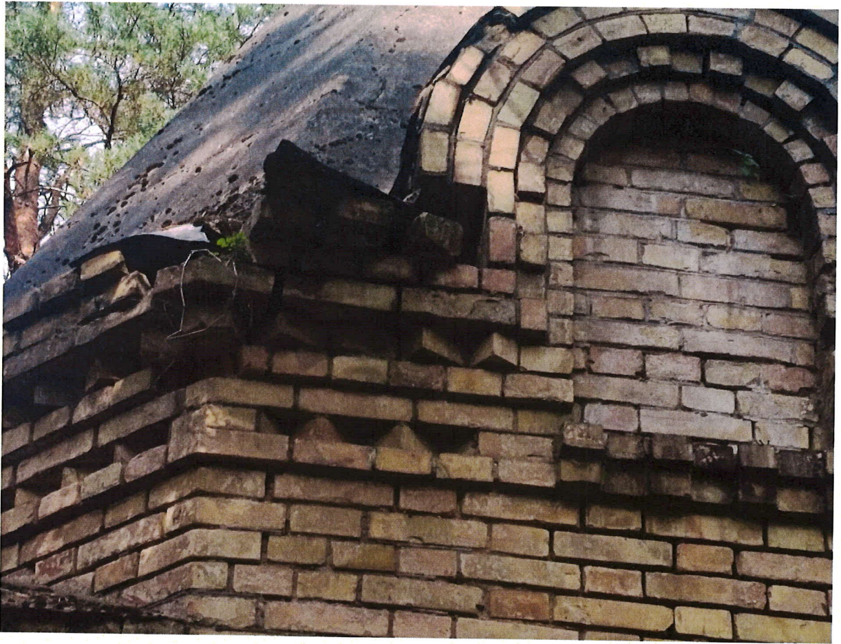
ZDJ.8 Widoczne fragmenty obróbki blacharskiej na okapach
