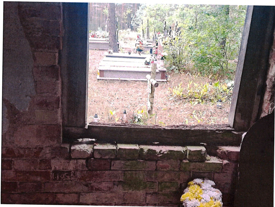
ZDJ.12 Detal otworu okiennego. Brak jest skrzydła okiennego, pozostała górna belka ościeżnicy. Górna i dolna belka ościeżnicy jest wmurowana w ścianę
