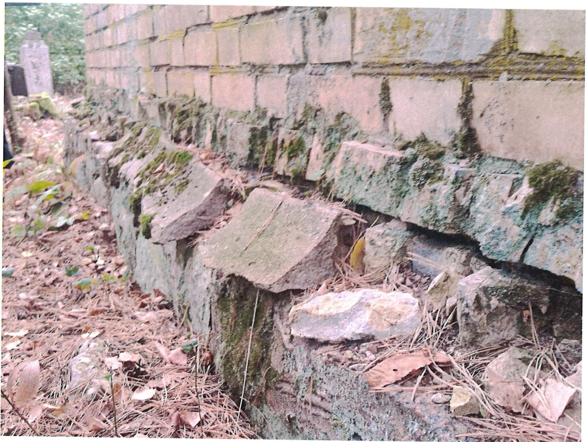
ZDJ.7 Szczątkowe fragmenty cokołu murowanego i betonowego nad fundamentem kamiennym
