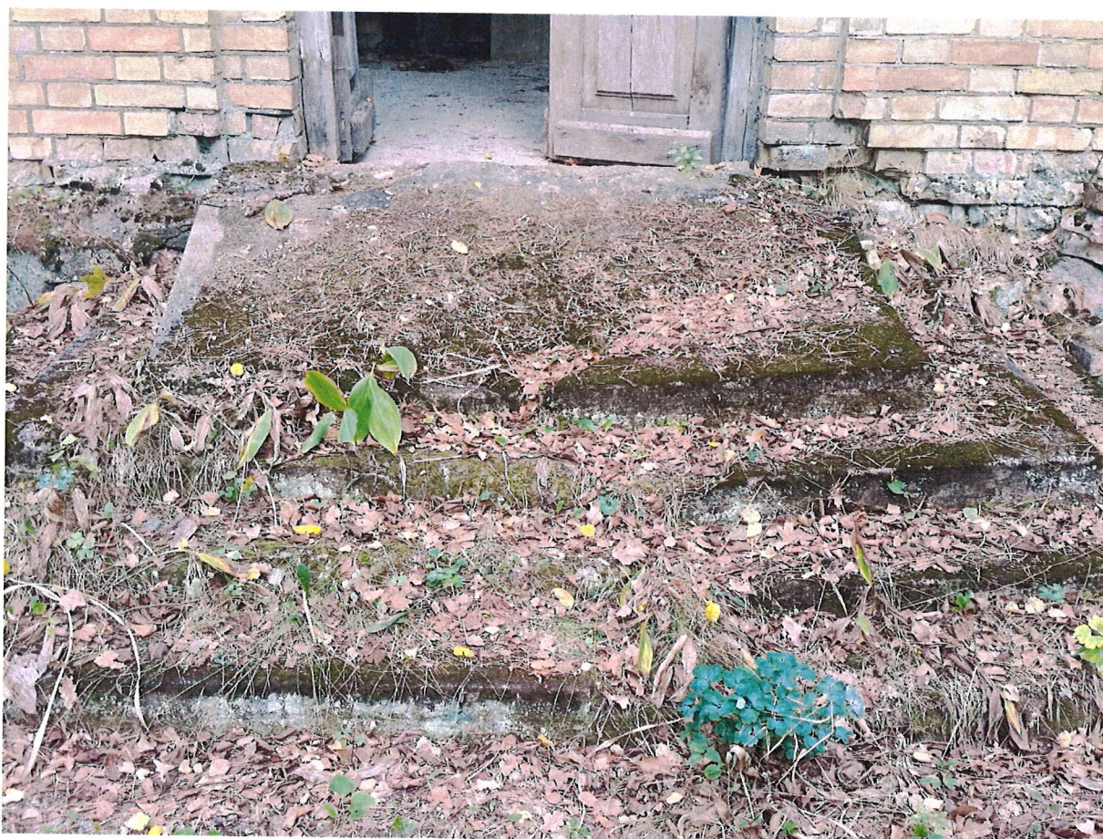
ZDJ.5 Widok schodów betonowych przed wejściem
