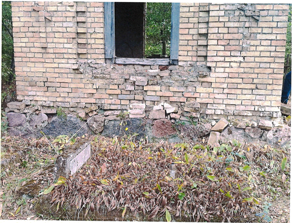
ZDJ.6 Szczątkowe fragmenty cokołu murowanego i betonowego nad fundamentem kamiennym
