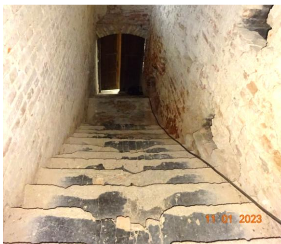
Fot.22 Wewnętrzne schody wejścia Nr I na piętro synagogi
