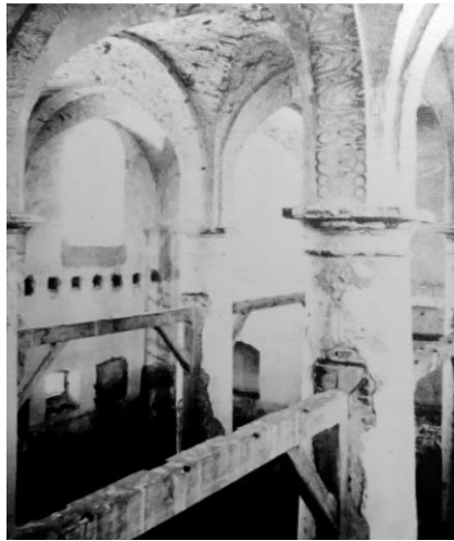
Fot.33 Historyczny ruszt pod deski podłogi magazynowej
