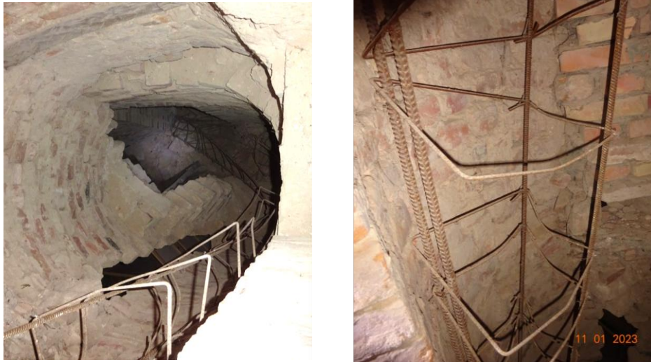
Fot.10 Tunel schodów spiralnych z przygotowanym zbrojeniem konstrukcyjnym
