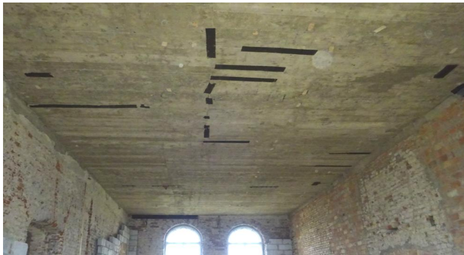
Fot.14 Strop żelbetowy nad piętrem od strony zachodniej synagogi
