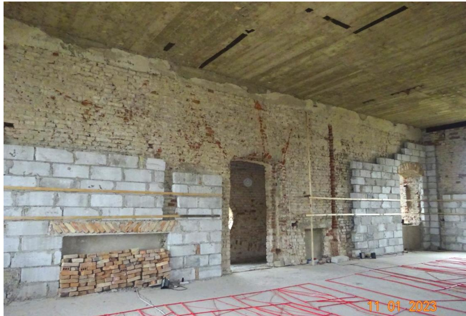
Fot.8 Mur ściany konstrukcyjnej stykający się z klatkami schodowymi (Nr I , Nr II) Rozpoczęto docieplanie od wewnątrz za pomocą bloczków gazobetonowych.
