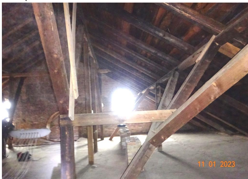
Fot.16 Wieżba dachowa .Ciemny kolor elementów drewnianych wynika ze stosowania do oleju impregnacyjnego (kreozotu)
