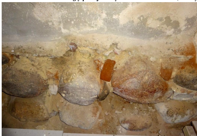
Fot. 4 Fragment fundamentu pod wschodnią ścianą szczytową W pobliżu niedokończony kanał centralnego ogrzewania
